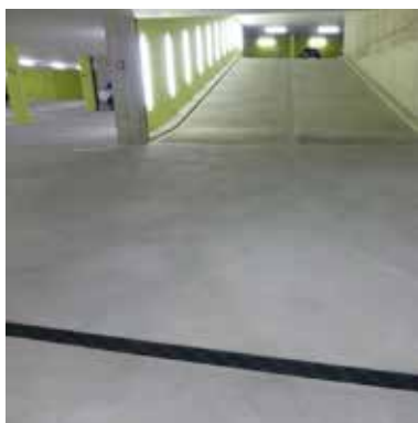
AquaStop u betonu
