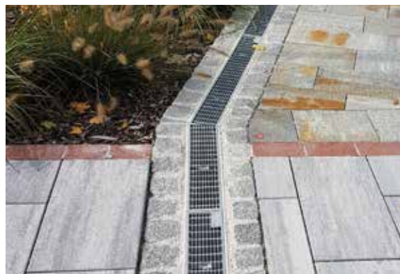
Odvodni kanal s prešanom mrežastom rešetkom širine oka 30/10
